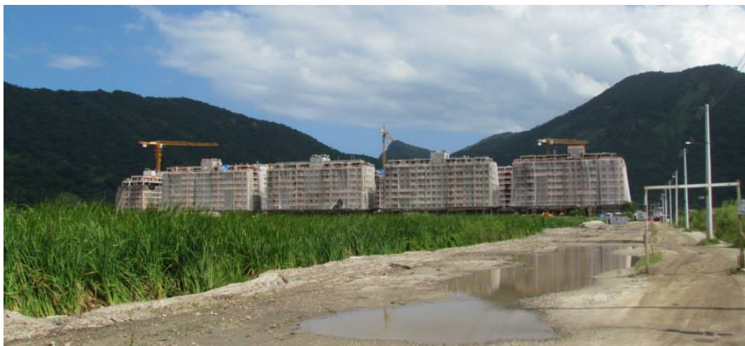
Foto 21- Vila Atletas Olímpicos - adensamento sem infraestrutura. Foto: Miguel Christino, 2014.
