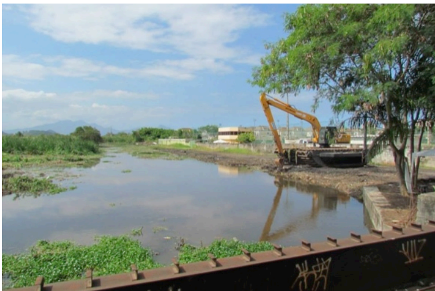
Foto 22 - Atterramento de terreno alagado para construção imobiliária
