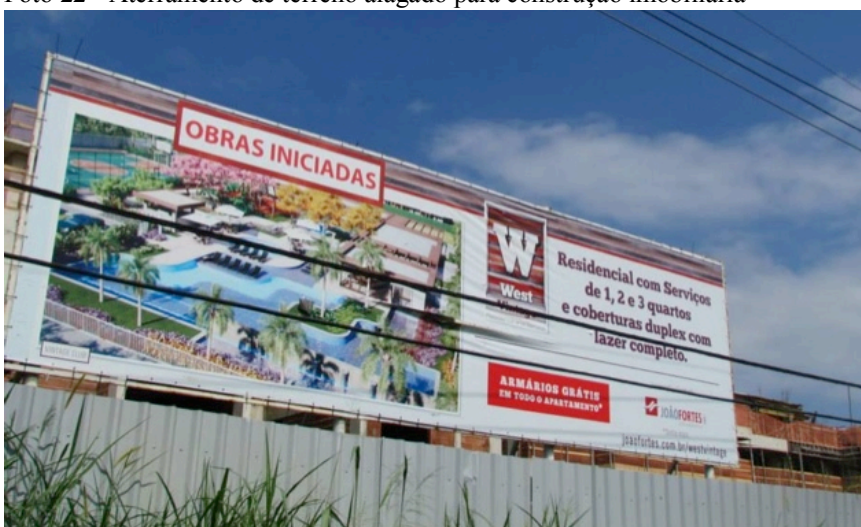
Foto 23 - Canteiro de obras de luxuoso condomínio Autora das fotos 22 e 23: Renata Boff, 2014.
