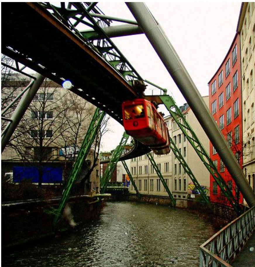
Foto 42: Trem suspenso em Wuppertal, Alemanha.
