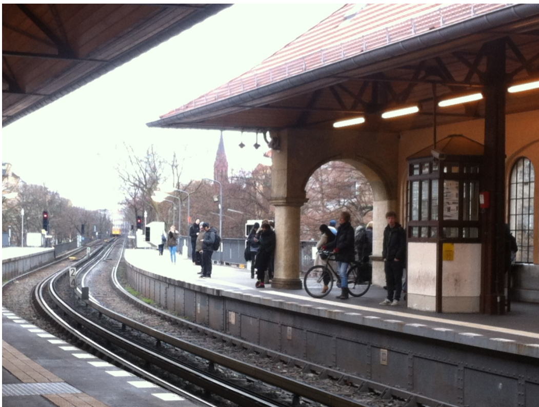
Foto 37: Acesso de bicicleta no metrô U1, estação Schlesisches Tor, Berlim 2016.
